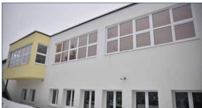
2022. - DOGRADNJA ŠKOLE „BEHAUDIN SELMANOVIĆ“ BRIJEŠĆE
